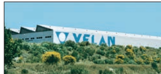
Lisbon, Portugal Velan Válvulas Industriais, Lda.
